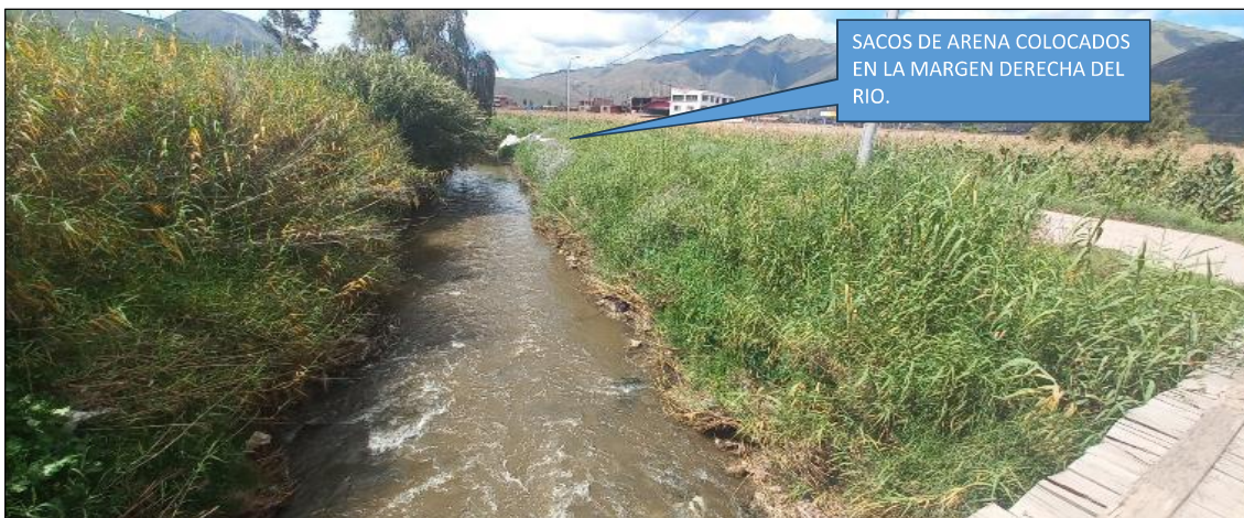
FOTOGRAFIA N° 03: TRAMO CRÍTICO EN EL RIO HUATANAY, EXPUESTO ANTE UN DESBORDAMIENTO EN EL CERCADO A LA POBLACION, SE APRECIA LA COLOCACION SE SACOS CON ARENA EN LA MARGEN DERECHA.
